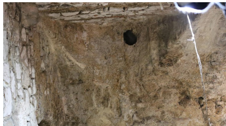
Otvori na svodovima za nekadašnje septičke jame (foto: Ana Doljanin)
