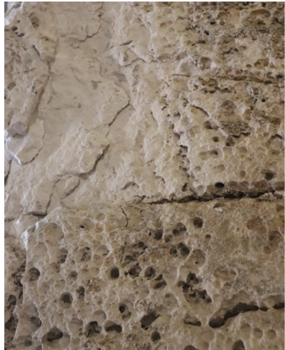
Vidljivi tragovi brašnastog osipanja. Ljuskanja i nedostajuće površine uslijed djelovanja soli na kamenu pilona u dvorani 11 A (foto: Ana Doljanin)
