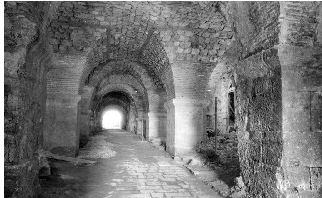
Pogled na ulicu kroz dvoranu 11 A tijekom radova obnove pilona i svodova, a prije iskapanja donje zone (Fototeka URBS-a)
