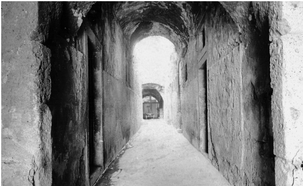
Pogled na ulicu kroz dvoranu 11 A prije radova izvedenih 50-ih i 60-ih godina 20. st. (Fototeka URBS-a)
