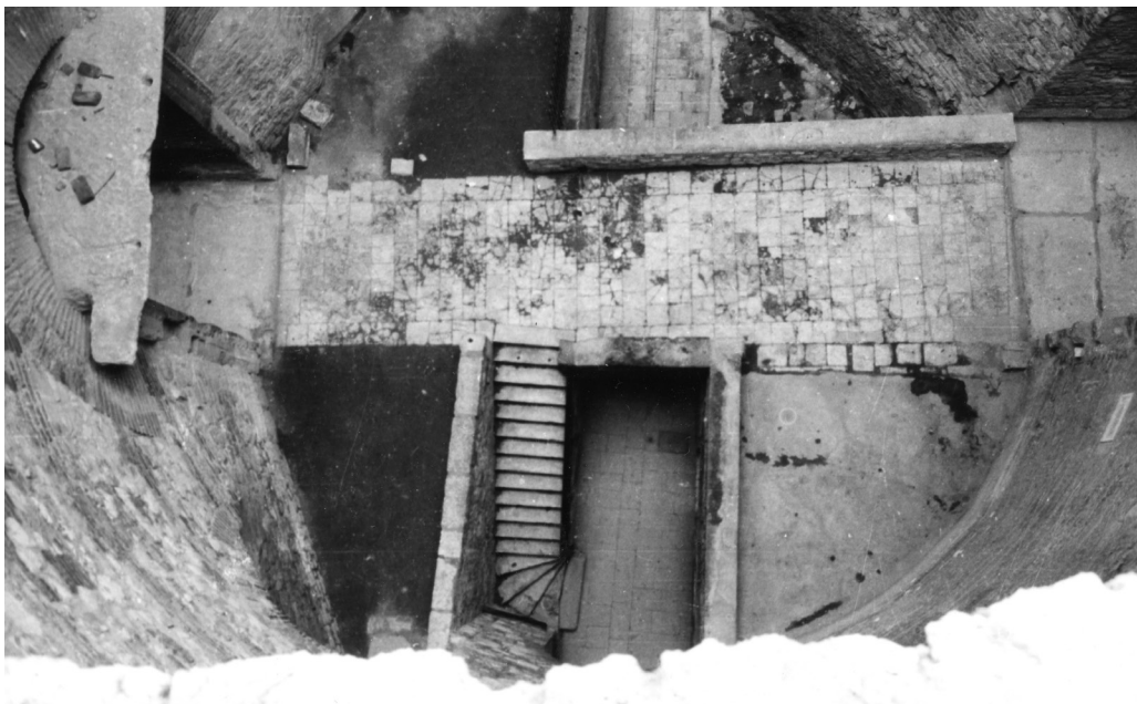
Pogled na ulicu i stepenište unutar Vestibula prije radova obnove (Fototeka URBS-a)
